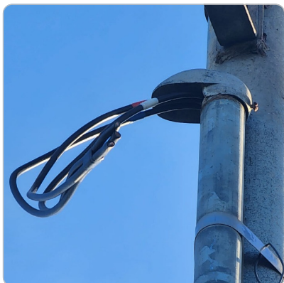
Sobra para Conexão com a rede
