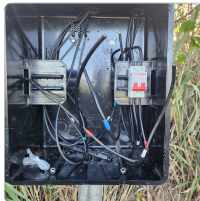
Cabos em espera do medidor
