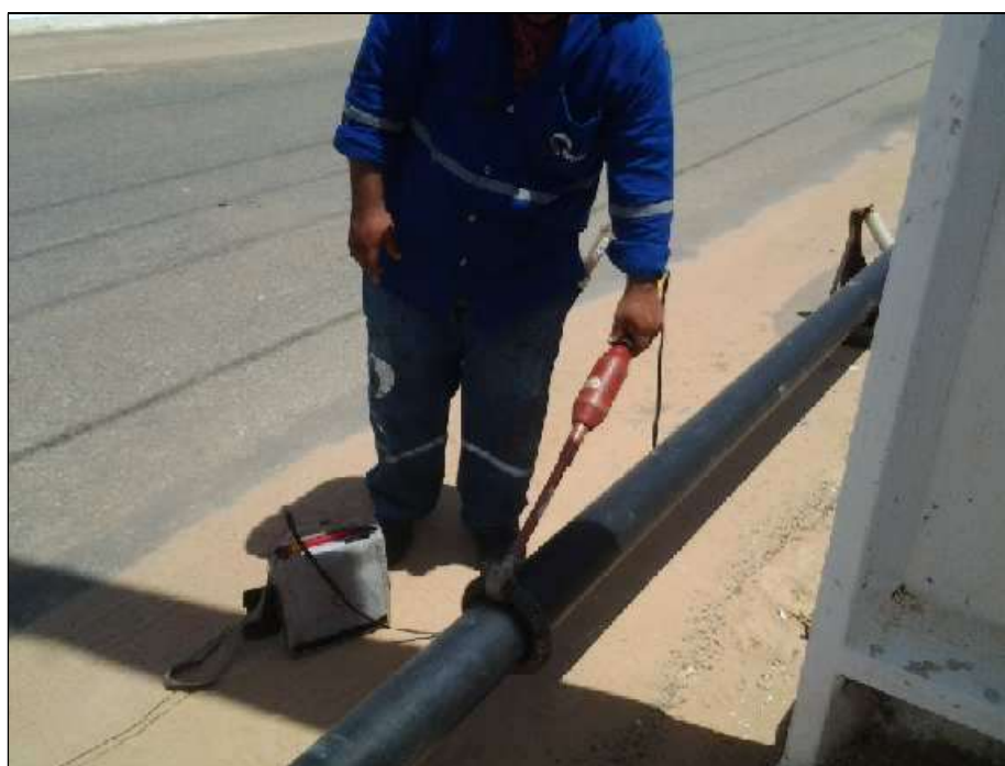
Figura 31 – Inspeção de revestimento com “Holiday Detector”.
