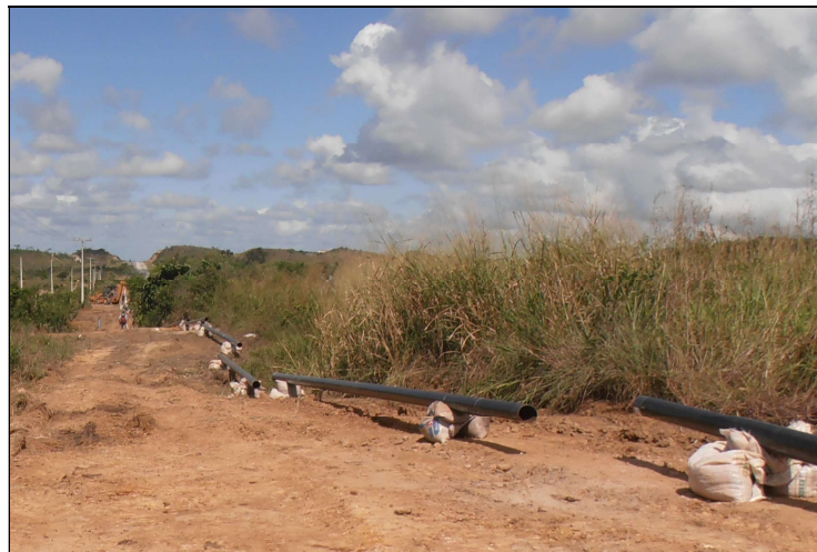
Figura 7 – Desfile de tubos na obra do ramal Vidros Nordeste 30/05/2014.
