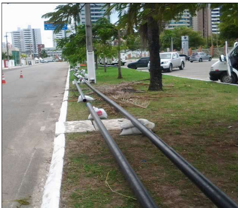
Figura 2 – Tubulação apoiada em sacos de areia fina
