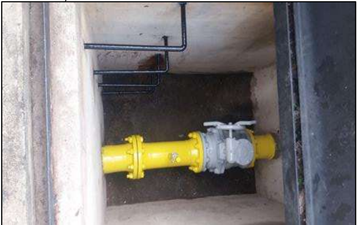
10.37CXA0075 (Cruzamento da Rua Francisco Gumerindo Bessa com a Rua Dr. Wilson Rocha).
