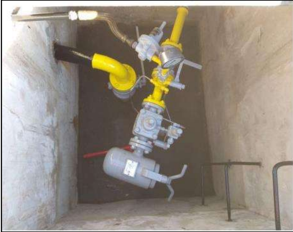
10.26CXA0059 (Cruzamento da Av. Melicio Machado com Rua Depurado Clovis Rollemberg)
