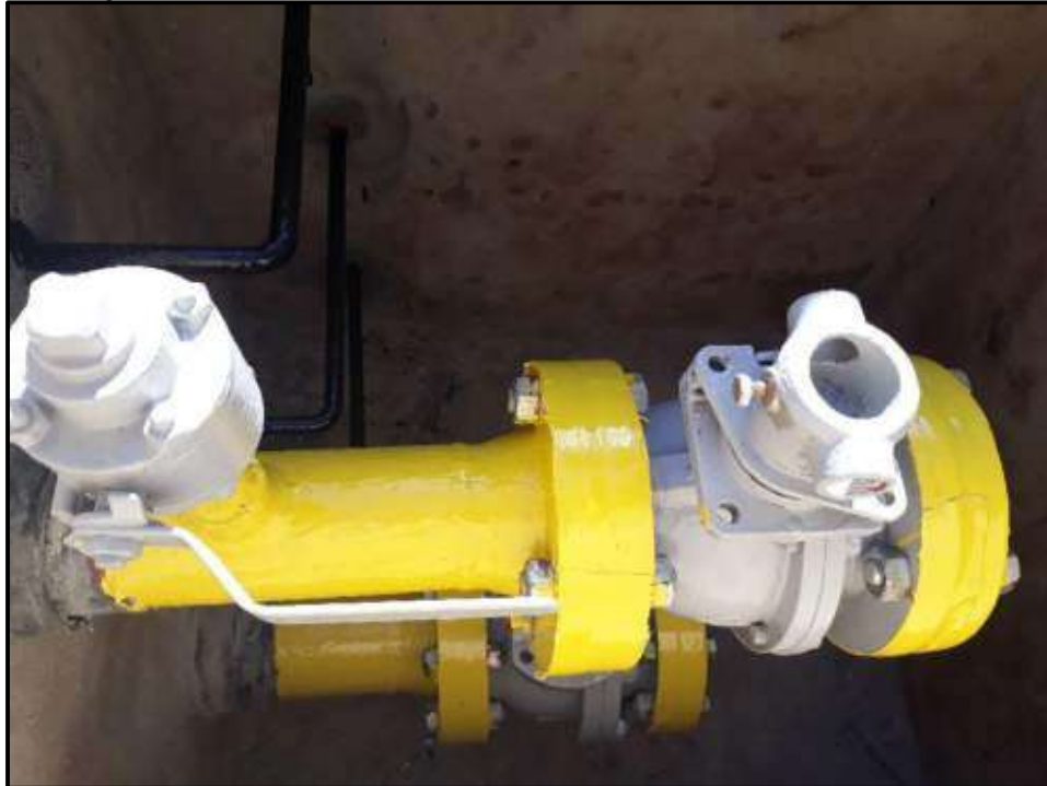
10.58CXS0034 (Av. Industrial Sadi Gitz, calçada da Cerâmica Capri – seguindo ao lado direito da portaria)
