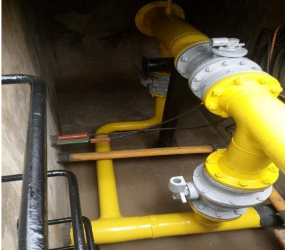
10.31 CXA0035 (Canteiro central da Av. Tancredo Neves, em frente ao Hospital de Urgência de Sergipe - HUSE).
