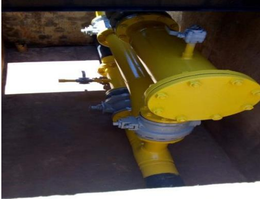
10.33 CXA0037 (Canteiro central da Av. Tancredo Neves, em frente à Secretaria de Estado da Fazenda).
