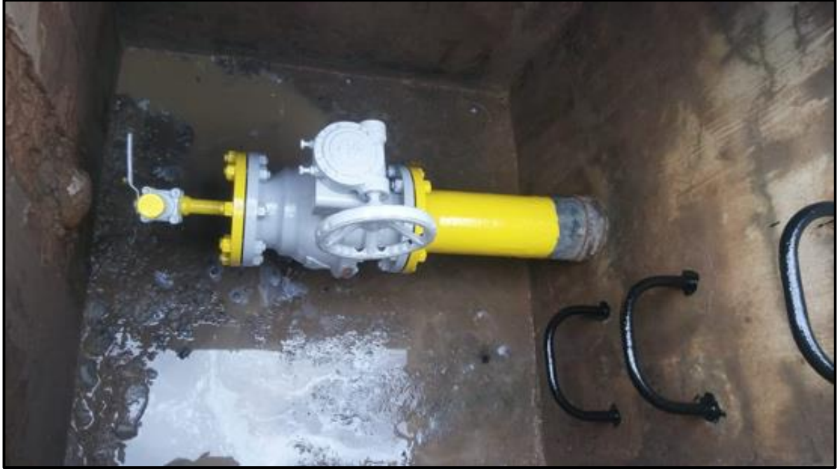
10.47 CXE0011 (BR-101, próximo aos outdoors na frente da Indústria Vidreira do Nordeste - IVN).
