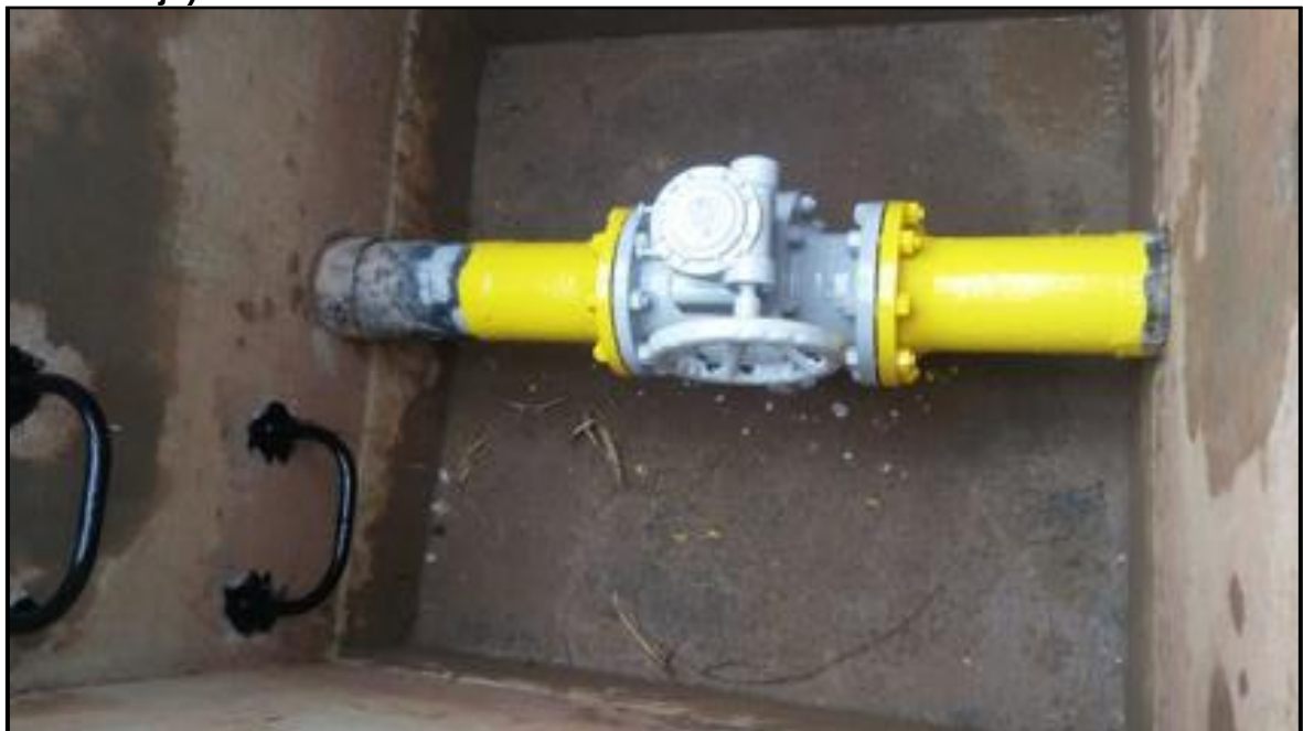
10.54 CXE0018 (BR-101, na travessia do ramal Vidreira do Nordeste, sentido Estância-Aracaju).
