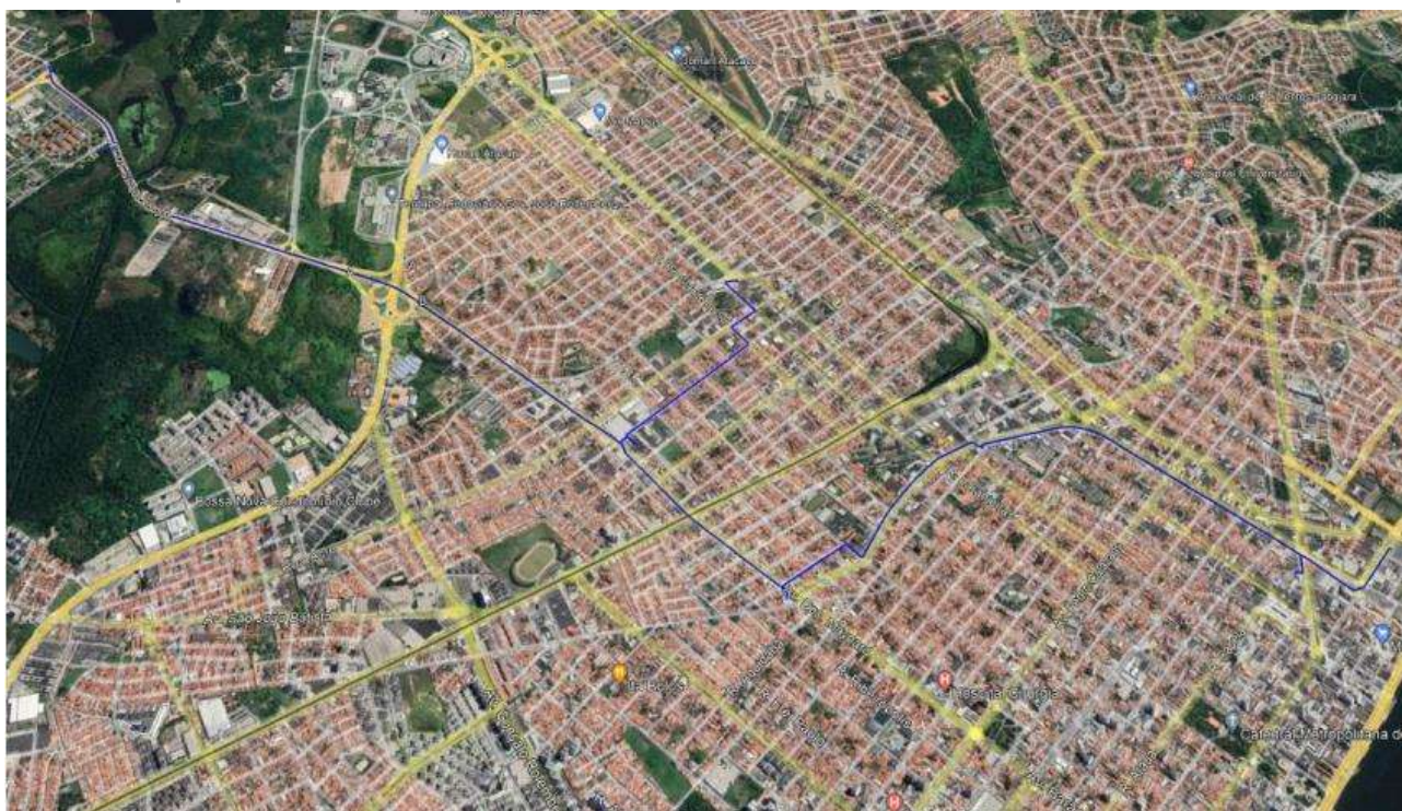
Figura 1 - Trecho do Duto.
