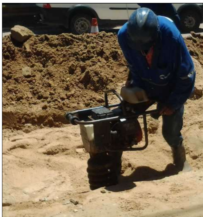
Figura 33 – Compactação mecânica com o uso de compactador de solo à percussão
