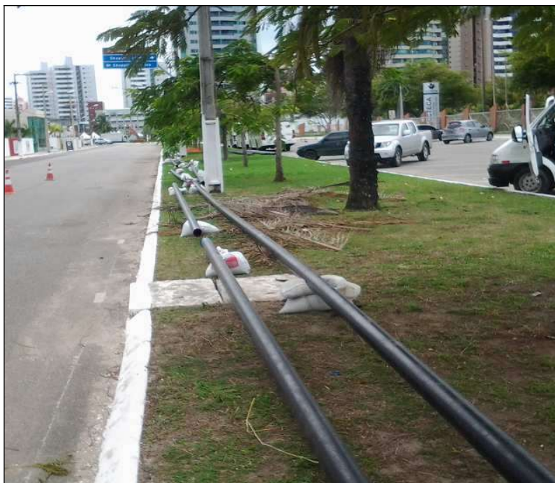
Figura 2 – Tubulação apoiada em sacos de areia fina
