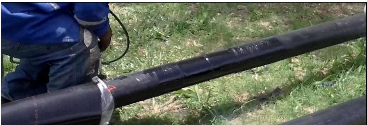
Figura 25 – Aplicação do primer na superfície do tubo
