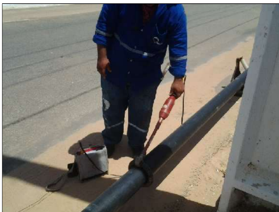
Figura 31 – Inspeção de revestimento com “Holiday Detector”.
