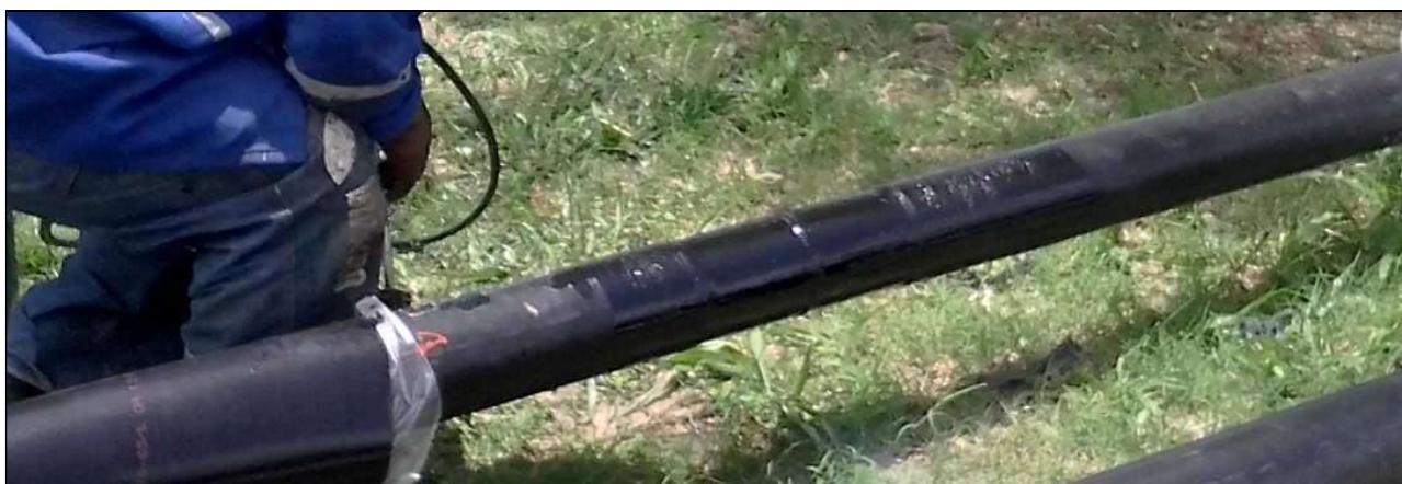
Figura 25 – Aplicação do primer na superfície do tubo
