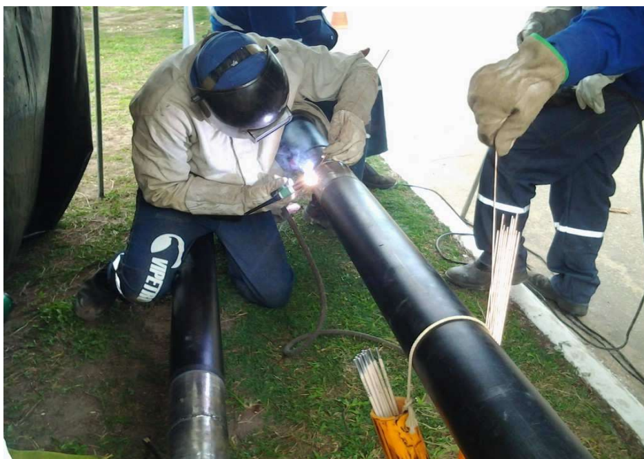
Figura 16 – Processo de solda.
