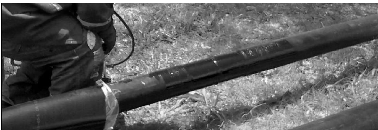
Figura 25 – Aplicação do primer na superfície do tubo
