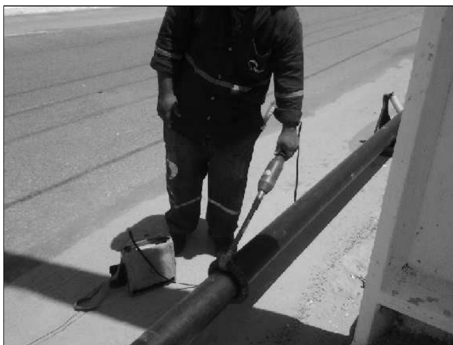
Figura 31 – Inspeção de revestimento com “Holiday Detector”.
