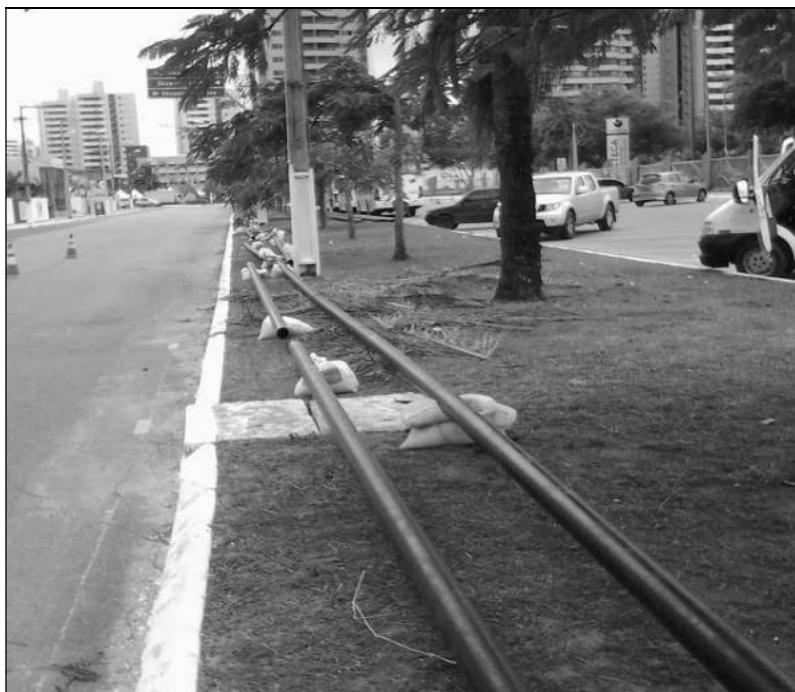
Figura 2 – Tubulação apoiada em sacos de areia fina
